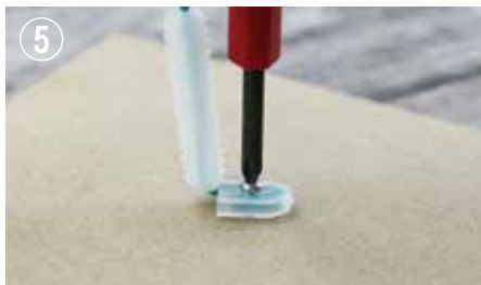
⑤ キリで台に穴をあけて位置を決め、留め具にネジを通して、プラスドライバーでネジをしめて足を固定します。
